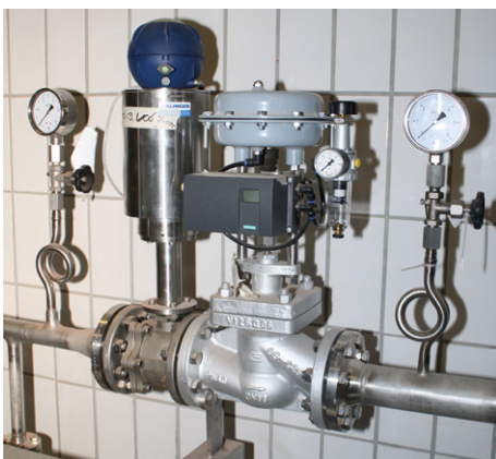
Stoomregelstraat met Klinger KFM regelkleppen en Ballostar kogelkraan.
