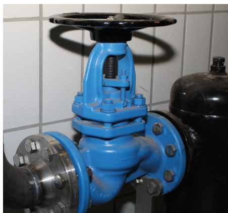
Stoomsysteem met originele Klinger plunjer-afsluiters type KVN.
