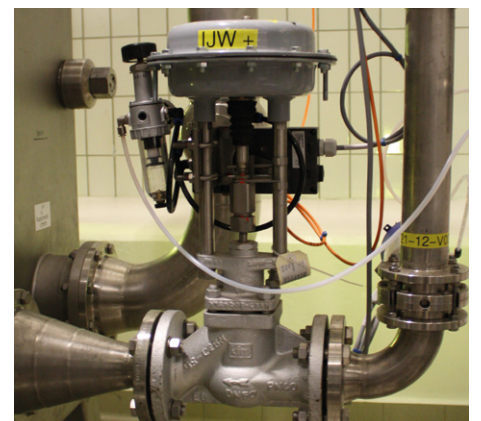
Procesregeling met Klinger KFM regelkleppen
